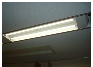
日本ローカルネットワークシステム (近畿本部) 様 大阪府大阪市 事務所 【蛍光灯の代替として2種類のタイプ をテスト付け中です】
