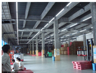
村岡運輸(株)様 大阪府寝屋川市 事務所、倉庫内 【蛍光灯の代替】
